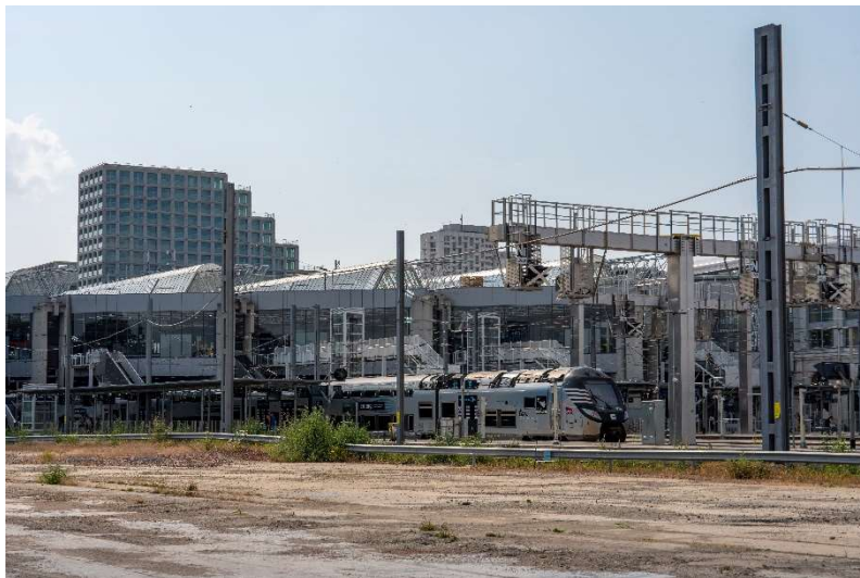
Vue sur la gare depuis le technicentre
