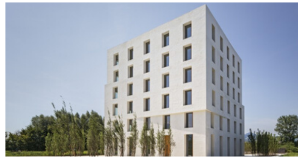
Bâtiment 2226 @Baumschlagler Eberle
