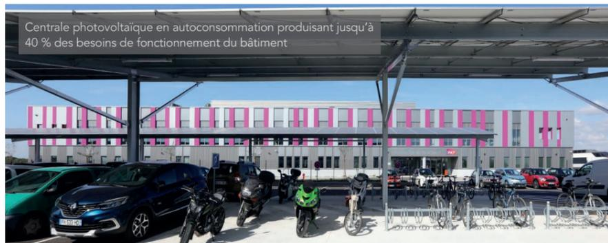
Bardage double peau identique sur les parties tertiaires et industrielles pour une isolation thermique performante réduisant les consommations
