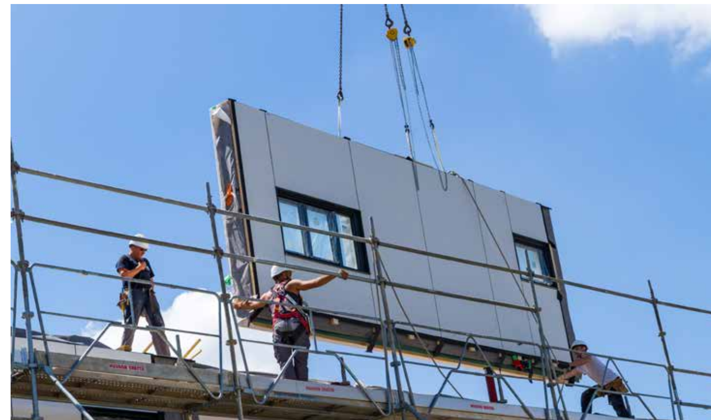
ICF HABITAT NORD-EST - LONGUEAU - POSE DE FAÇADE - RÉNOVATION ENERGIESPRONG
