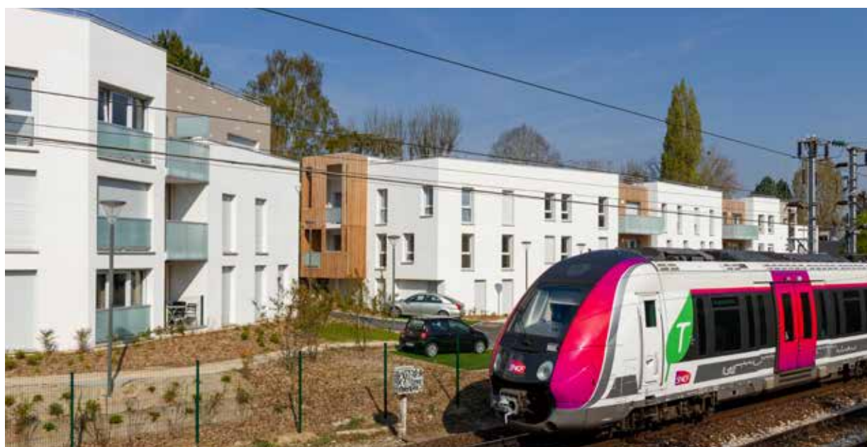
ICF HABITAT NOVEDIS - AVENUE DE LOUVECIENNES 78170 LA CELLE SAINT-CLOUD 22 LOGEMENTS
