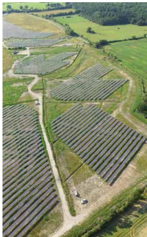
LA FERME PHOTOVOLTAÏQUE DE SURDON DANS L'EURE
