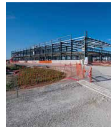
PREMIERS TRAVAUX DU TECHNICENTRE DE ROMILLY
